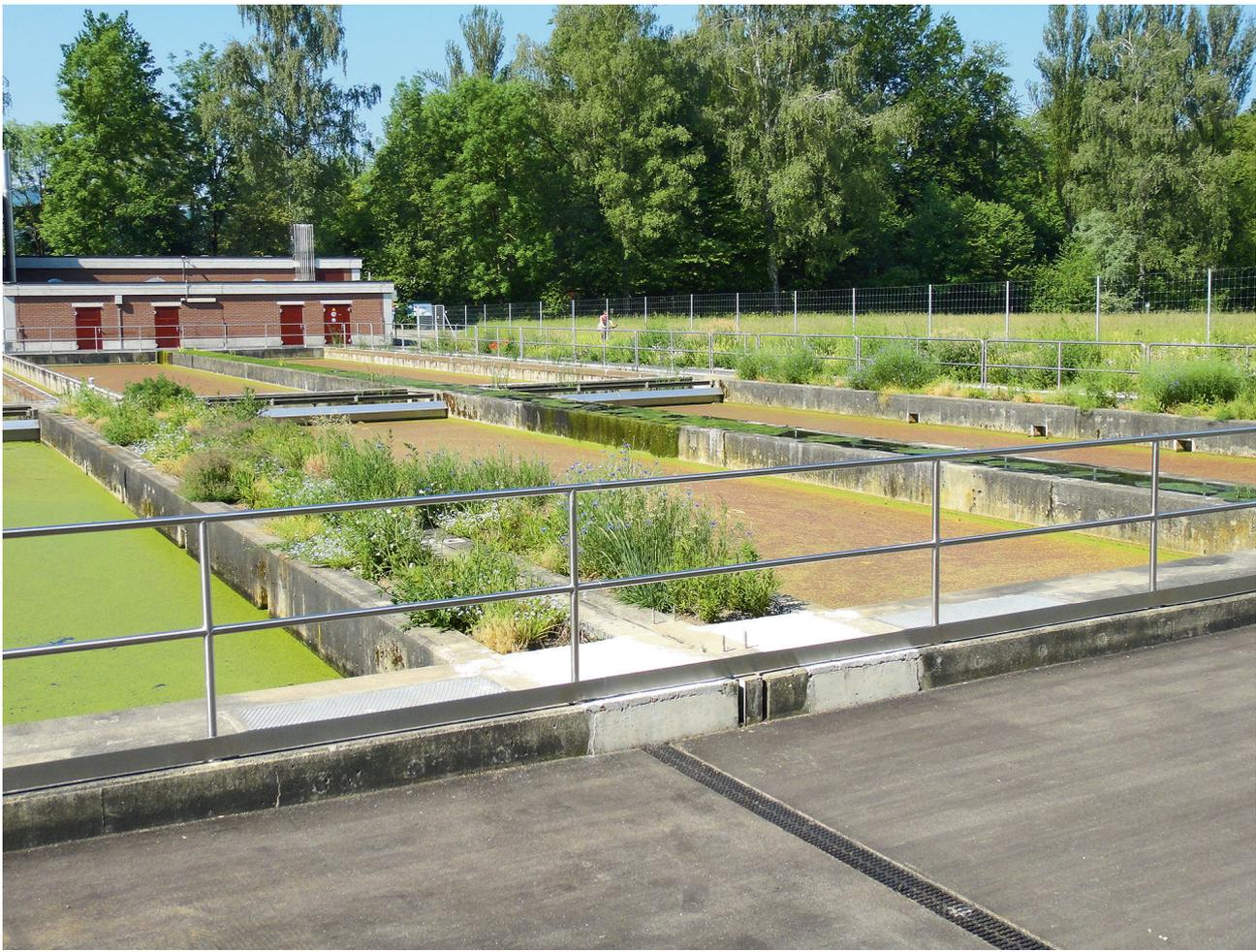
Fig. 2 Die Begrünung der früheren Klärbecken erfreut heute die Passanten. Einmal im Jahr muss die Bepflanzung zurückgeschnitten werden, dafür konnte jedoch auf den aufwendigen Rückbau der Becken verzichtet werden.
